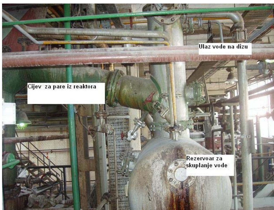
Slika 3.9-1: Skruber reaktora 5
