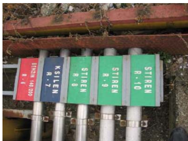
Slika 3.6-1: Lokacija istakališta za podzemne spremnike otapala i monomera (lijevo) i prikaz mehanizma za punjenje podzemnih spremnika (desno)
